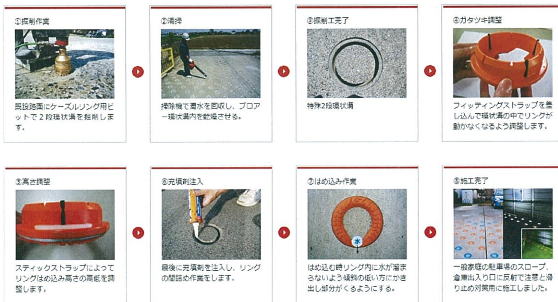
図-1 ケーズル工法の施工フロー
